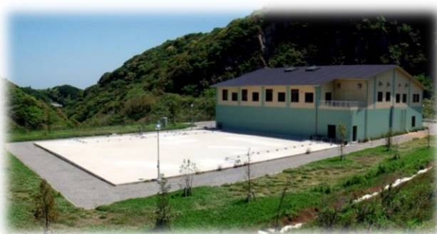
浸出水処理施設
