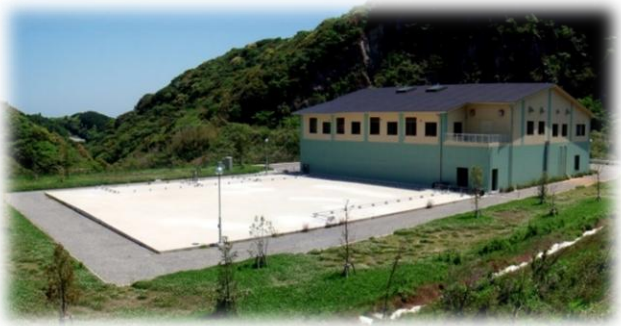
浸出水処理施設
